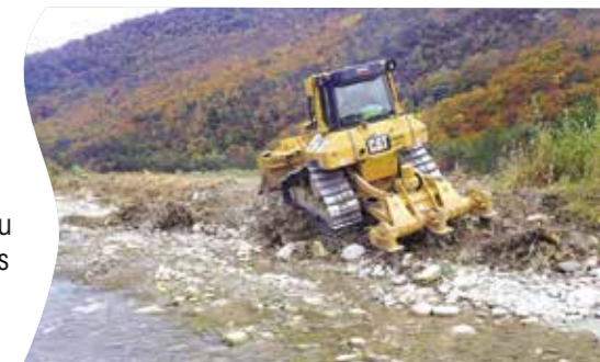
Scarification d'un banc de galets dans le lit du Grand Buëch
