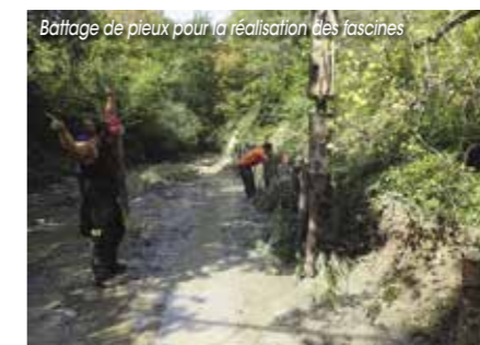
Battage de pieux pour la réalisation des fascines
