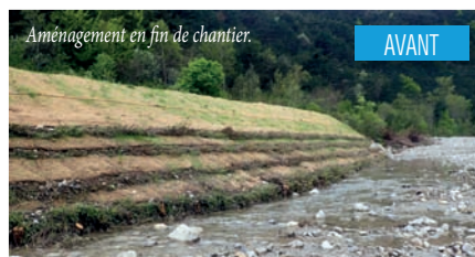
Végétalisation quelques mois après travaux.
