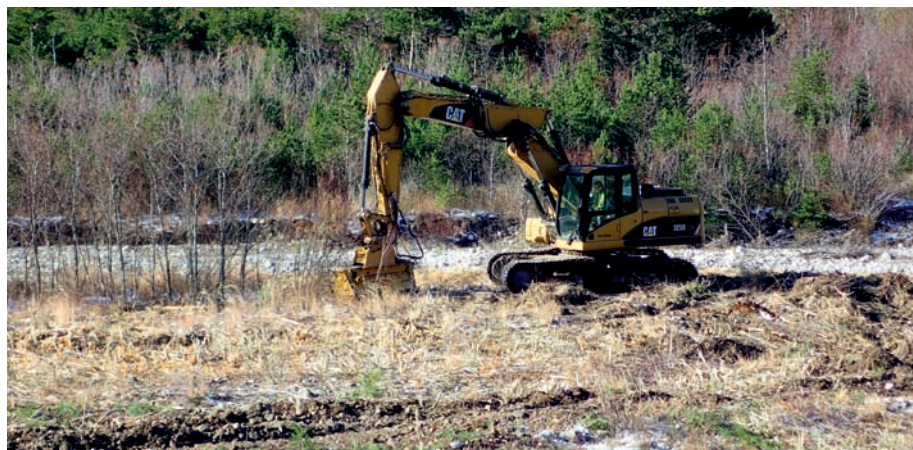
Passage du godet ripper pour la scarification
