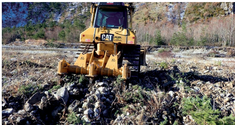
Passage du godet ripper pour la scarification
