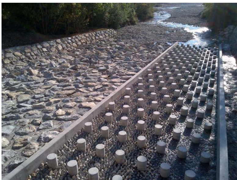
Photo 1 : Passe à poissons au Pont des Savoyons (3 octobre 2014)
