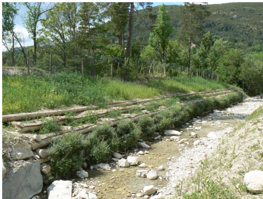
Photo 2 : Caissons végétalisés en confortement de la digue de Bouriane
